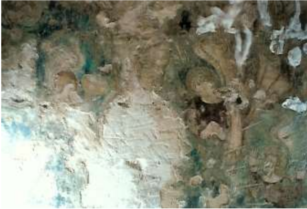
Détail de la même zone en cours de traitement (régénération).
