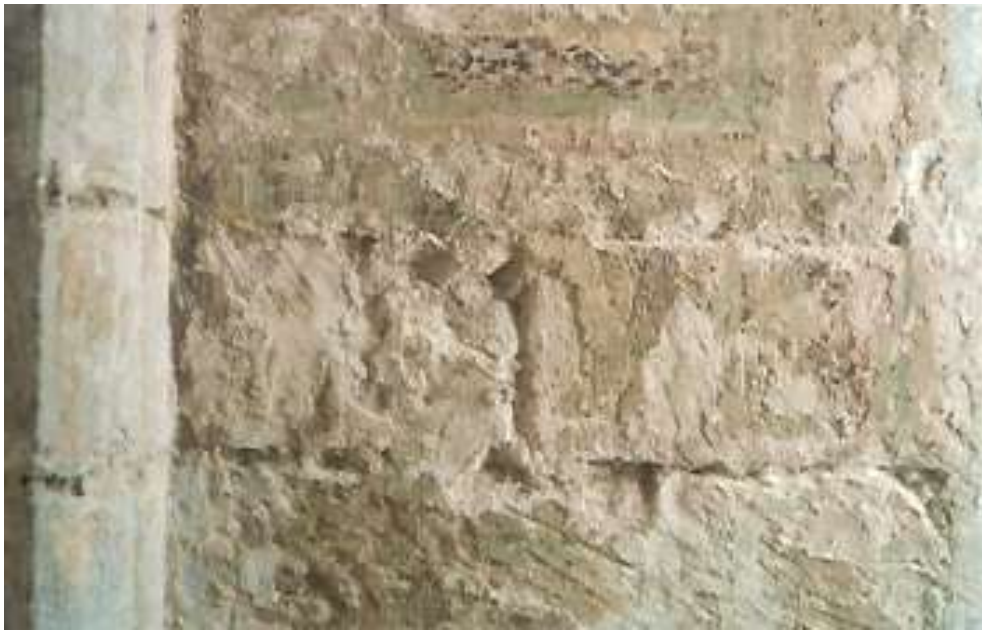
Détail de l'angle en partie inférieure, côté nord, avant intervention.
