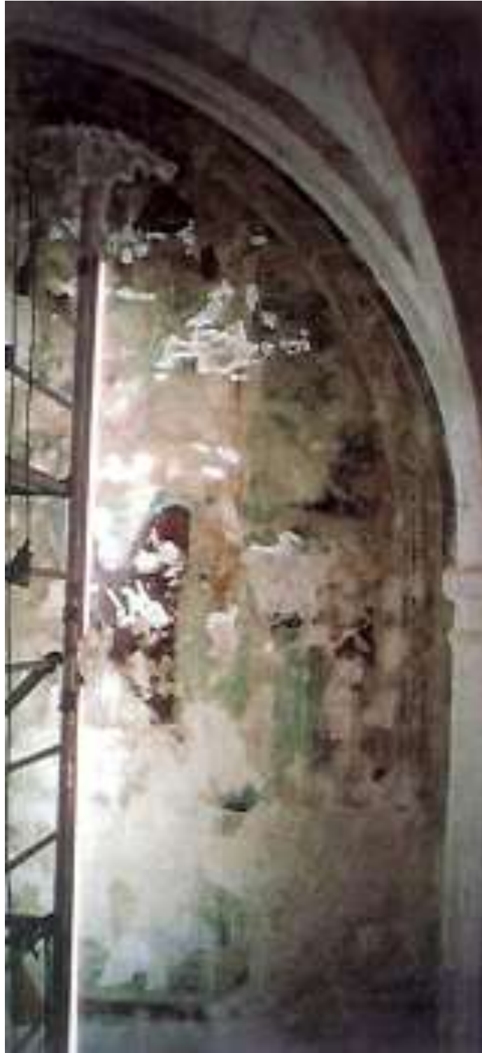
Vue générale côté sud en cours de traitement.
