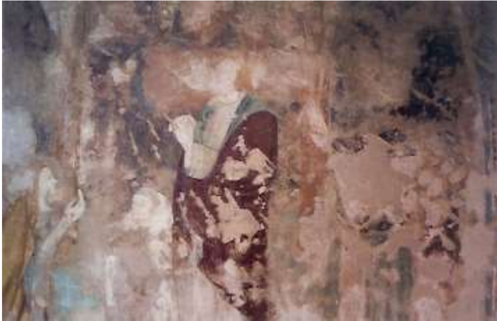
Détail de la zone médiane après intervention.
