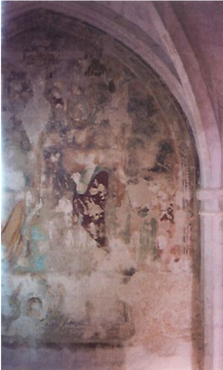
Vue générale côté sud après la pose d'enduits de restauration.
