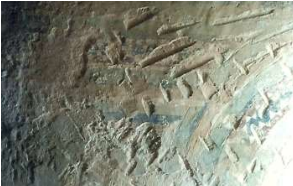
Détail des traces de piquetage près du médaillon central, en partie inférieure.
