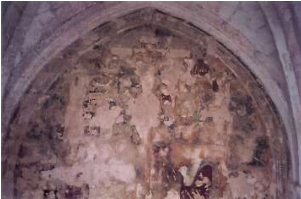
Vue générale du mur après pose des enduits et traitement chromatique.
