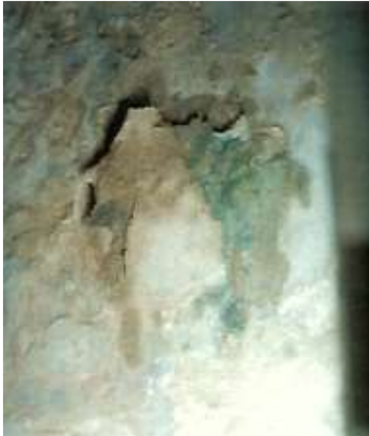
Zone d'enduit non adhérent recouvert d'un enduit postérieur.
