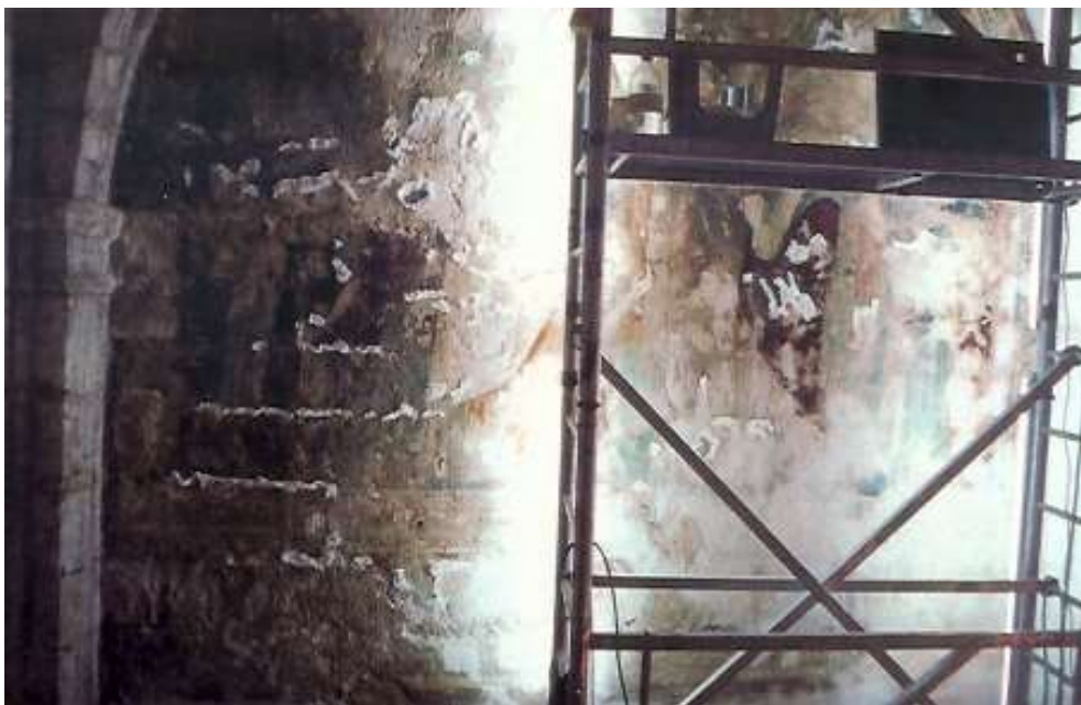
Vue générale en cours de traitement (régénération de la couche picturale).
