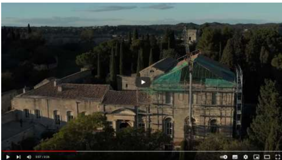
Restauration de la toiture en 2021-2022. Pour ouvrir la vidéo, cliquez ici
