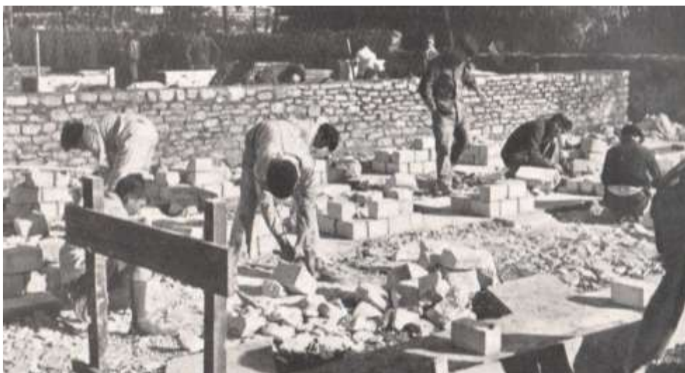
Chantier dans le Vaucluse – 1941.
