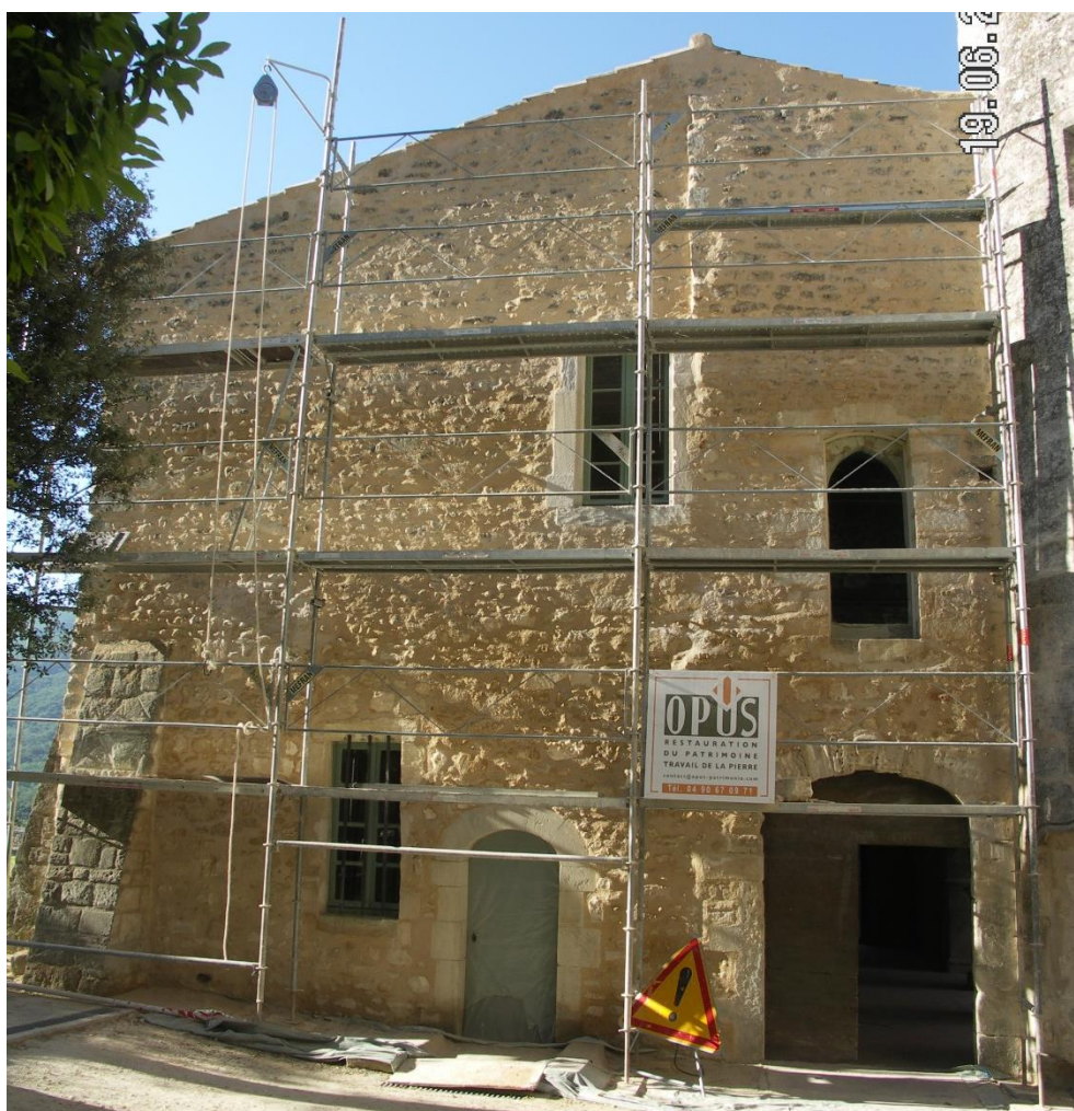
Façade nord du bâtiment conventuel est – 2008.
