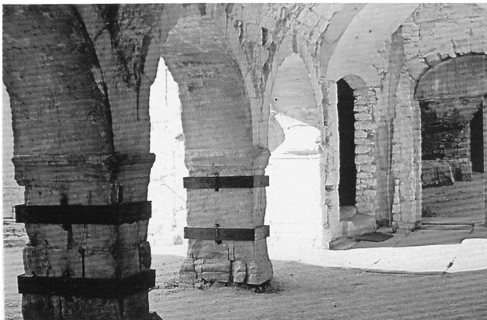
La voûte de la galerie à l'est est en pierre établie en berceau brisé, formant des berceaux et divisée en quatre travées par des arcs-doubleaux composés d'un rang de claveaux, correspondant aux piliers des arcades.
