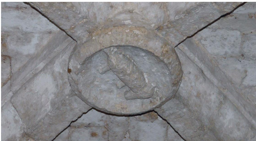
Fig. 8 : Dans la chapelle latérale, au plafond, la belle croisée d'arceaux.
