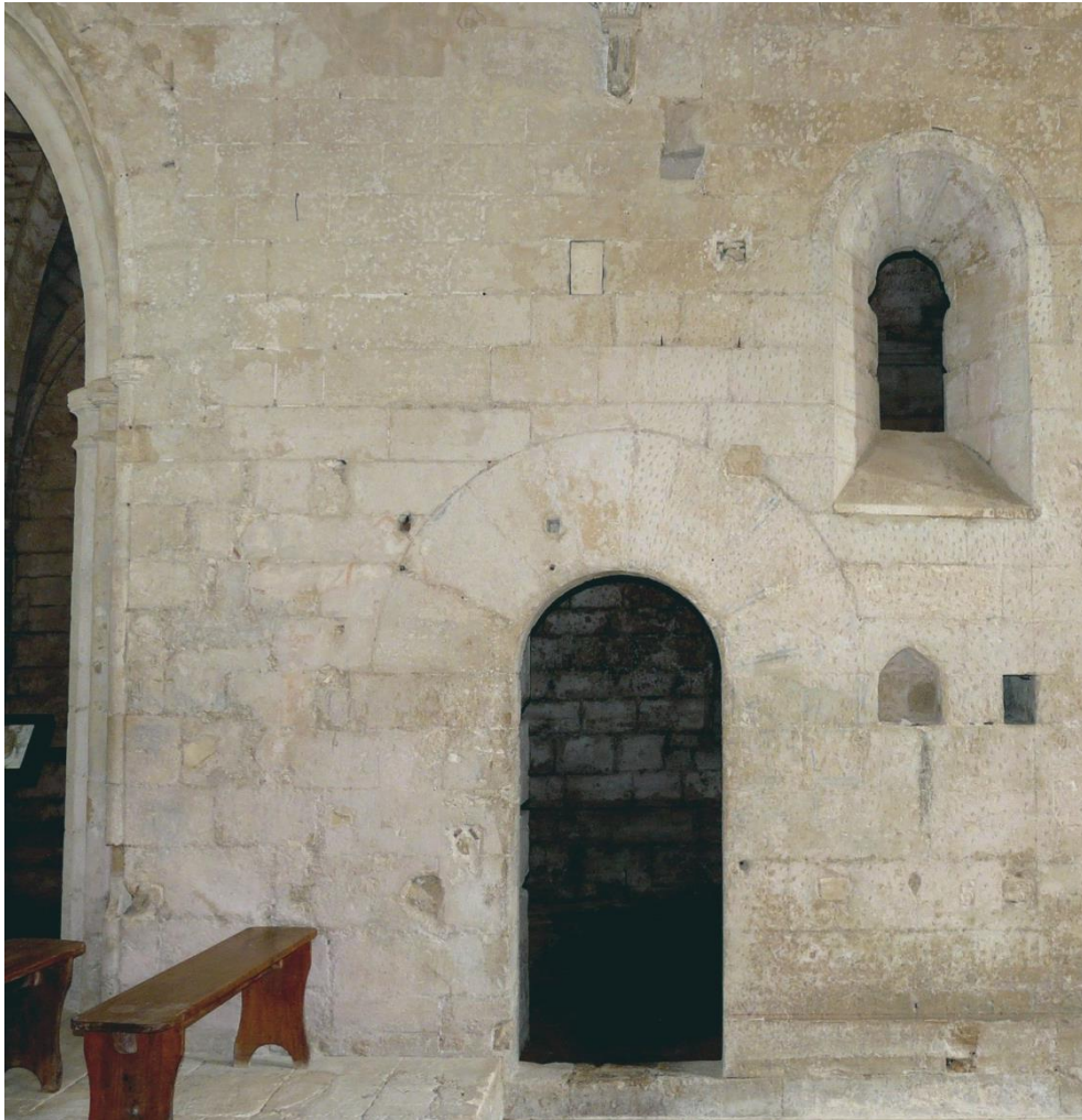
Fig. 9 : A gauche, l'entrée de la chapelle annexe, au centre, la porte donnant sur la sacristie.
