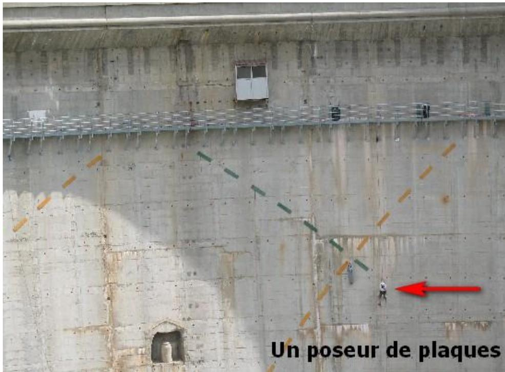
Le cadran, construit sur une surface de 13.000 m<sup>2</sup> (la voûte du barrage fait 100 m de haut et 200 m de large) permet de lire l'heure solaire de 6h00 à 18h00. Chaque heure est matérialisée par une "ligne horaire" confectionnée avec des plaques en lave émaillée : ocres pour les heures du matin, vertes pour celles de l'après-midi.
