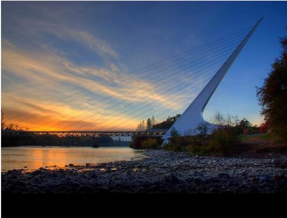
Passerelle pour piétons à haubans acier asymétriques, sans haubans d'ancrage et pylône incliné. La dalle est constituée de plaques de verre dépoli. La longueur totale de l'ouvrage est de 230 m, pour une portée de 150 m.
