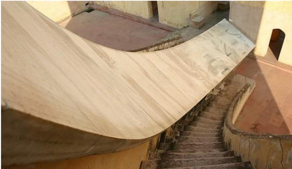
Le Ram Yantra, une structure cylindrique double qui permet de déterminer la hauteur et l'azimut des planètes par la lecture des graduations gravées sur les murs et le sol.
