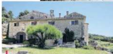
L'abbaye Saint-Hilaire abrite une partie de l'histoire des Carmes du XIII e siècle. C'est à cette époque que se sont installés les moines de cet ordre religieux vers le Mont-Carmel, en Terre sainte.
