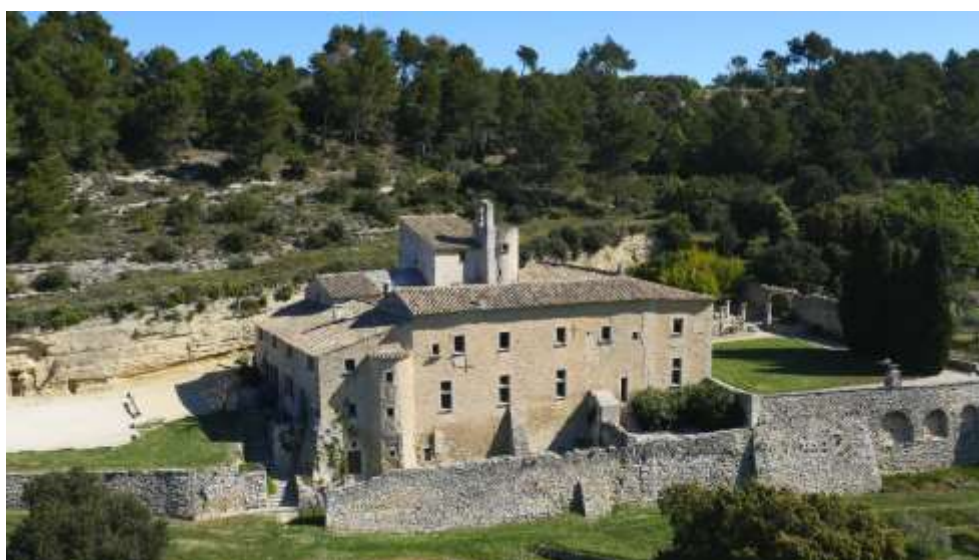
Façade sud du bâtiment conventuel. Pour agrandir le document, cliquez ici
